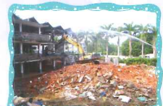
校門口及第一教學大樓前棟拆除
